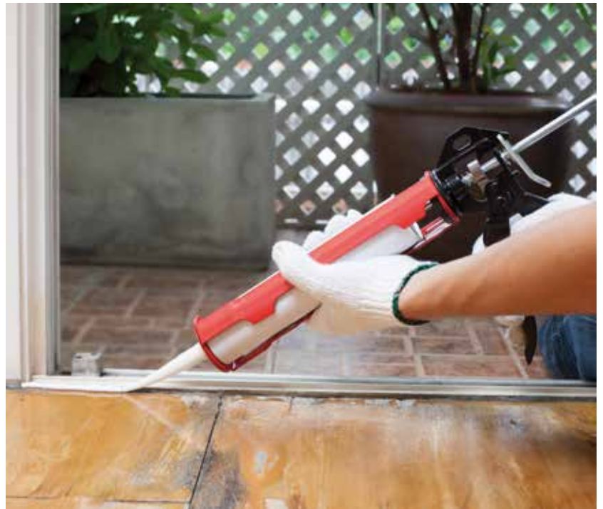
Figur 4c: Silikone-polymerens "rygrad" består af [-\text{Si}-\text{O}-]_x med ureaktive sidegrupper. Det gør silikone meget kemisk resistent, termisk stabil og vandafvisende. Materialet bruges derfor ofte som tætningsmiddel eller i husholdningsgenstande såsom grydelapper eller bageforme. Silikones egenskaber kan ændres ved at skifte sidekæderne på polymeren. (Foto: Colourbox)
