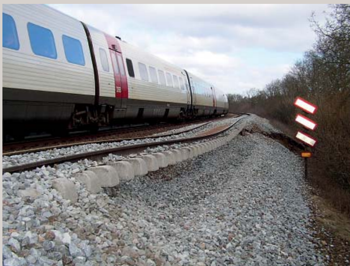
For cirka 10 år siden skred en cirka 100 år gammel banedæmning syd for Vejle udlagt over plastisk ler pludselig sammen. Foto: Torben Thorsen
