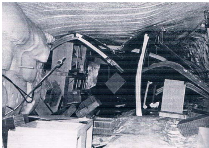
I sommeren 1969, tre år efter den definitive lukning af Camp Century, tog en fotograf udsendt af den amerikanske hær dette billede, der viser en sammenpresset mandskabstunnel i den få år tidligere så omtalte by i indlandsisen. Foto: Austin Kovacs.
