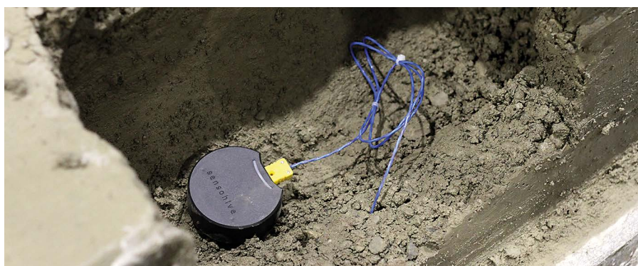
Foto af en betonsensor i aktion. Sensorkables støbes ind i den flydende beton, og efter brug klippes kablet blot over. Samlet får systemet input om temperaturen fra betonen, klimadata uden for betonen samt sammensætningen af betonen. Baseret på datainput beregner en algoritme styrken af betonen i realtid. En anden algoritme forudsiger ud fra det nuværende datasæt og lignende målinger, hvornår den støbte beton forventes at være færdighærdnet. Foto: Sensohive.
