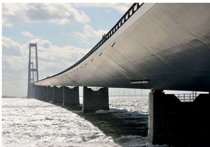
Bropiller er ofte udført i beton. Foto: Colourbox
