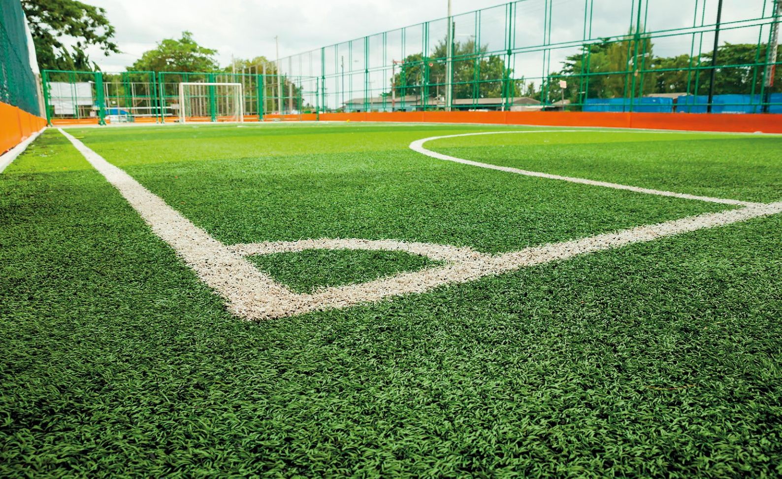
På mange ældre kunstgræsbaner til sportsbrug bruger man granulat fra gamle bildæk som ekstra fyld og støddæmpning imellem de grønne plaststrå. Det har været kutyme at efterfylde med granulat, da det "forsvinder" med tiden.
