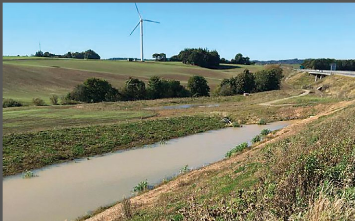
Vandet fra vejen passerer et regnvandsbassin efterfulgt af et filterbassin.
