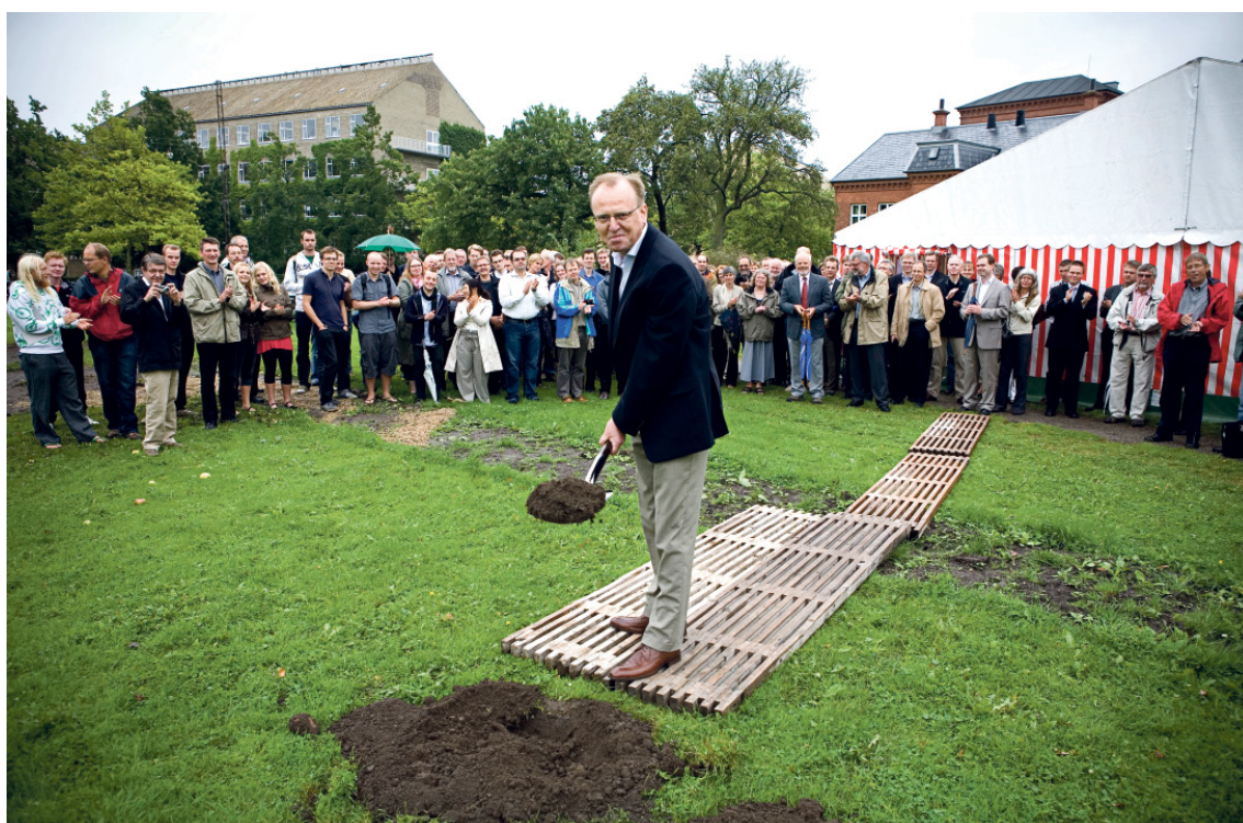
Det er med vemod, at Flemming Besenbacher siger farvel til iNANO et halvt år før den store flytning til det 10.000 m 2 store iNANO-hus ved kasernen. Her ses han tage det første spadestik til huset den 22. august 2007.
