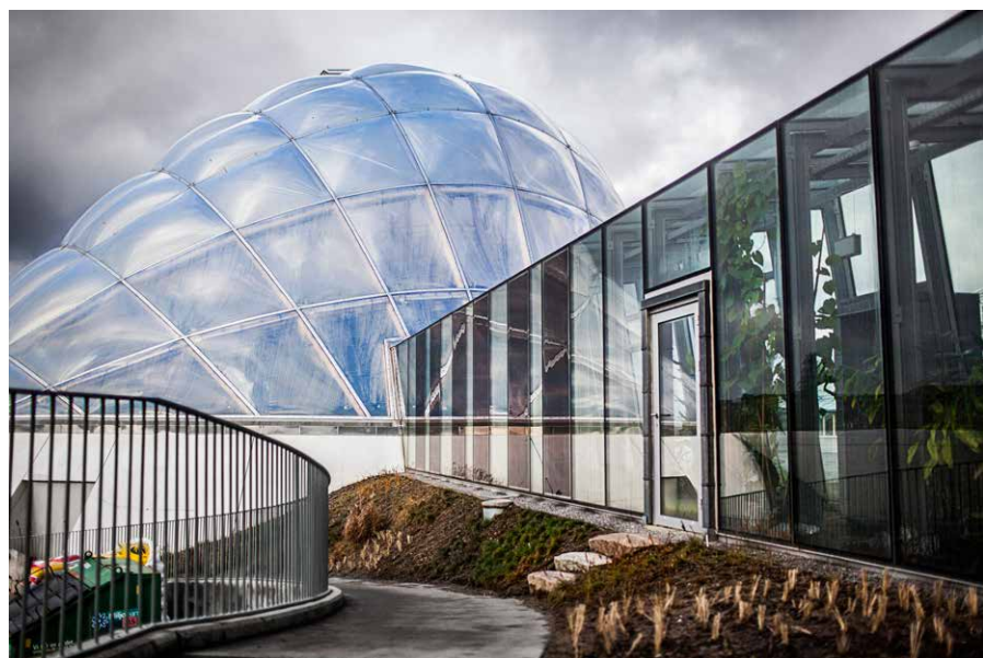
Kuplen i det nye tropehus er lavet af luftpuder i EFTE, som er et transparent foliemateriale, der reducerer tabet af varme, da EFTE isolerer som en termorude. Andre eksempler på bæredygtige teknologier i det nye tropehus er varmepumpeanlæg, regnvandstanke og solvarmepaneler.
